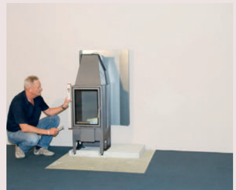
Kamineinsatz mit Wasserwaage einrichten Installer l'insert de cheminée avec un niveau à bulle
