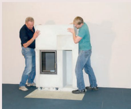
Verkleidungselemente Stück für Stück zusammensetzen und verkleben Assembler et coller les éléments d'habillage pièce par pièce
