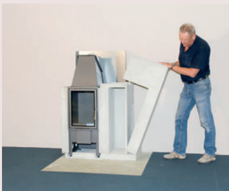
Verkleidungselemente Stück für Stück zusammensetzen und verkleben Assembler et coller les éléments d'habillage pièce par pièce
